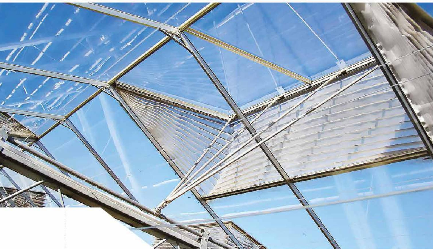
Конструкция держателя имеет форму короба, что при закрытой форточке позволяет антимоскитной сетке быть защищенной от осадков и атмосферных воздействий. Для нормальной работы форточек и адаптации к существующей кровле разработан новый коньковый шпрос.
