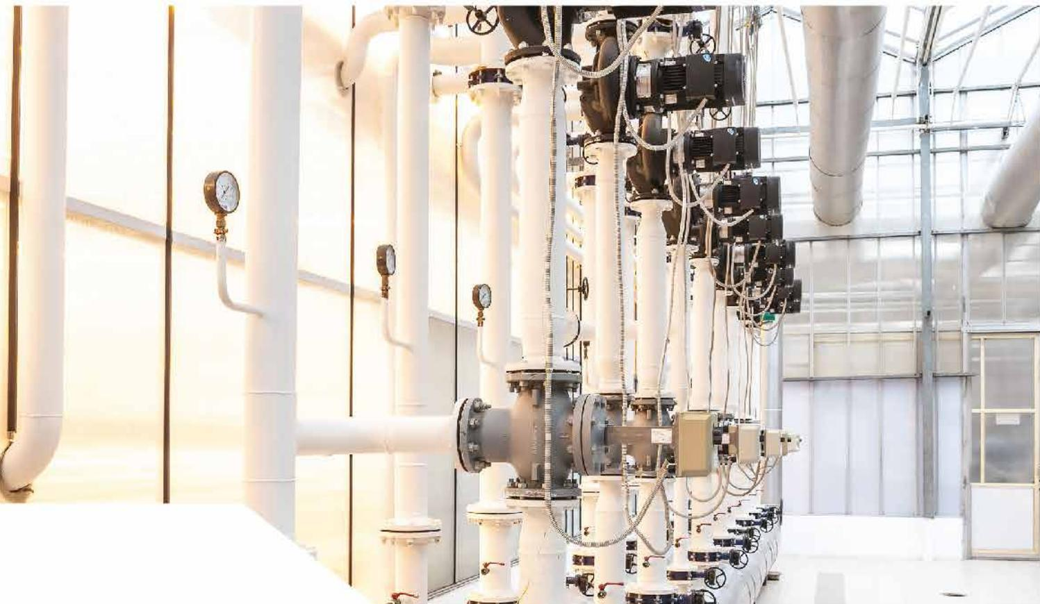
Расчет системы отопления производится исходя из климатических условий местонахождения тепличного комплекса согласно СП и СНиП. Компенсация теплопотерь обеспечивается контурами систем отопления с отдельным регулированием каждого контура. Расчет теплоносителя для каждого контура отопления осуществляется автоматически с учетом ограничений по температуре и времени, задаваемых требованиями технологии выращивания растений.
